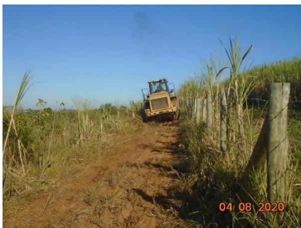
Foto 15 – Pá Carregadeira com Concha 950H efetuando a manutenção do aceiro.
