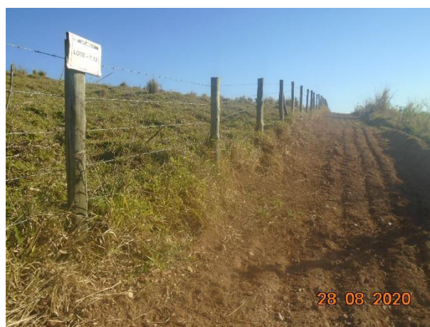
Foto 20 – Vegetação (gramíneas) removida na área do aceiro do sub lote 7.13
