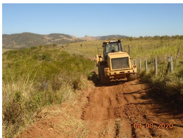
Foto 17 – Manutenção de aceiro efetuado de forma mecanizada.
